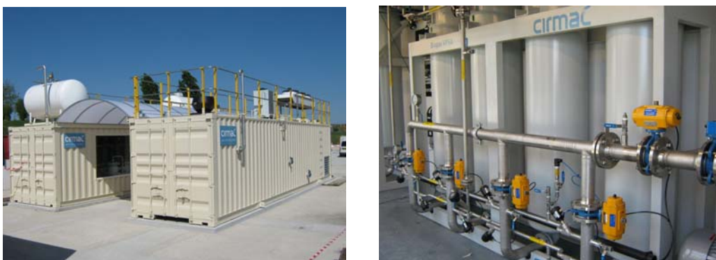
Figur 4.5 Uppgraderingsanläggningen levererad av Cirmac och installerad på en deponi i Frankrike som drivs av Veolia. 26
