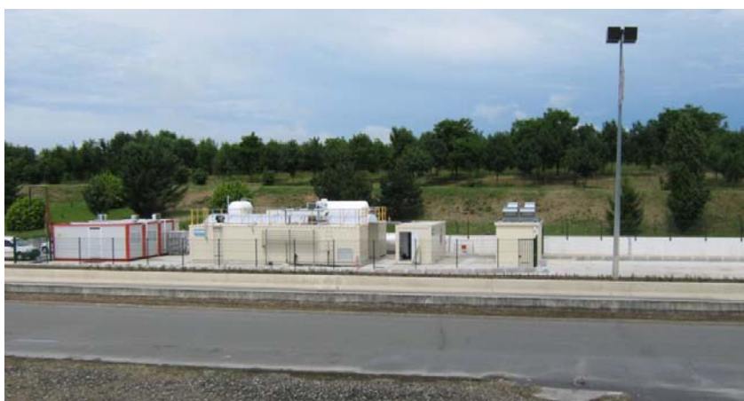
Figur 4.21 Anläggning från Cirmac för uppgradering av deponigas på en deponi i Frankrike. 41
